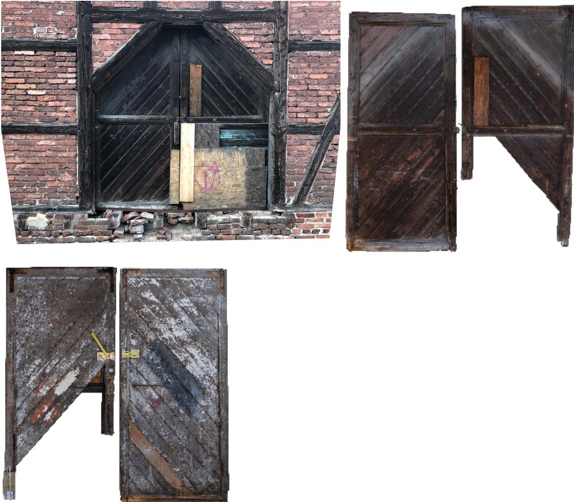
Die Rahmen beider Flügel sind im unteren Drittel stark verrottet bzw. nicht mehr vorhanden. Diese Teile lassen sich jedoch aus den Resten der originalen Schiebetore von der Trassenseite ergänzen. Auch die Gefachungen für die Flügel lassen sich aus den vorhandenen Resten ergänzen.
