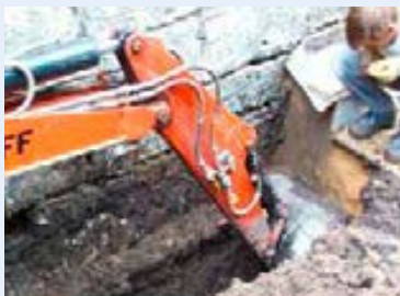
Freilegen des Fundamentes für den nächsten Bauabschnitt
