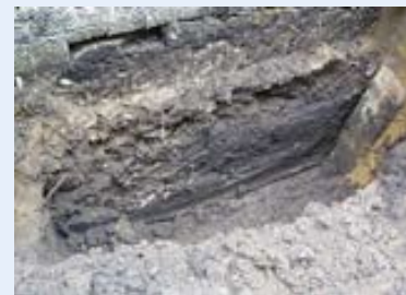
Holzbohle zum Schutz des fertigen Bauabschnittes
