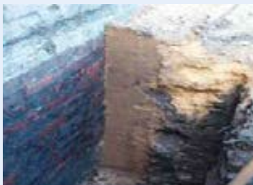
Fertiger Bauabschnitt, Holzbohle entfernt
