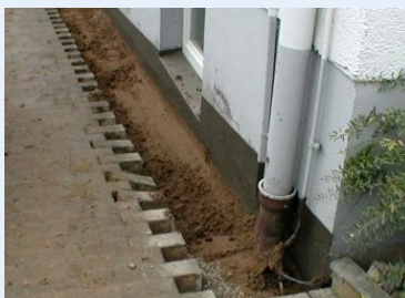
Oberflächenschutz aus Pflastersteinen darunter DERNOTON ® -Fertigmischung
