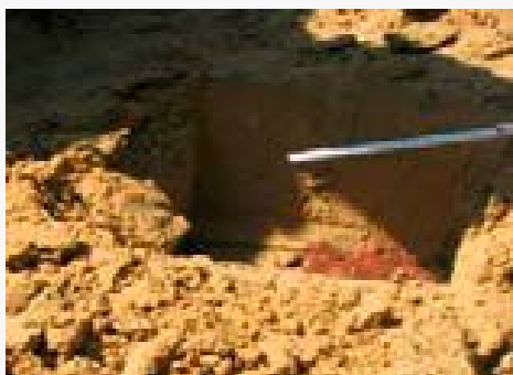
Abb.5: Überprüfen der Schichtstärke (ca. 0,2m)
