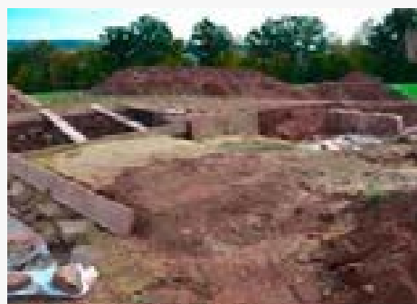
Nach Einbau und Verdichten der DERNOTON®-Fertigmischung BA (Foto: P. Wolters)
