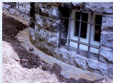
Oberflächenschutz aus Natursteinen
