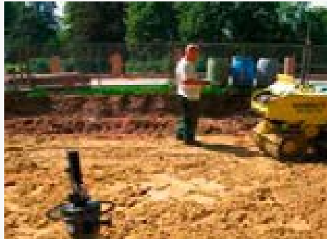
Abb.4: Verdichten der DERNOTON®-Fertigmischung BA (mind. 97% Proctordichte)
