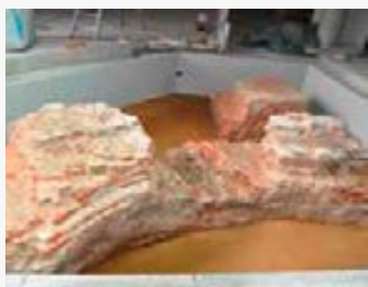
Turm- und Stadtmauerrest während der Restaurierung.
