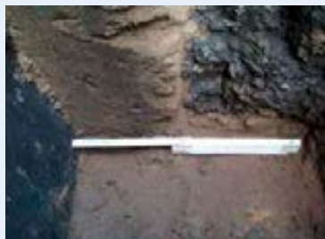
Kontrolle der Einbaustärke von 0,20 m
