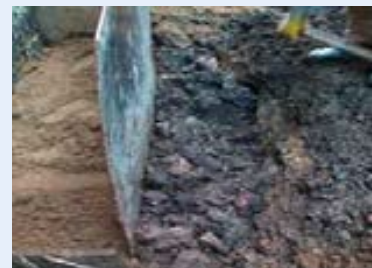
Trennstreifen während des Einfüllens
