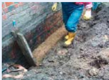
Holzbohle als Begrenzung des zu bearbeitenden Bauabschnittes
