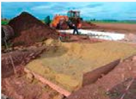
Einbau der DERNOTON®-Fertigmischung BA (Foto: P. Wolters)
